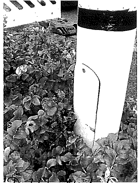
Defekte Abdeckung
