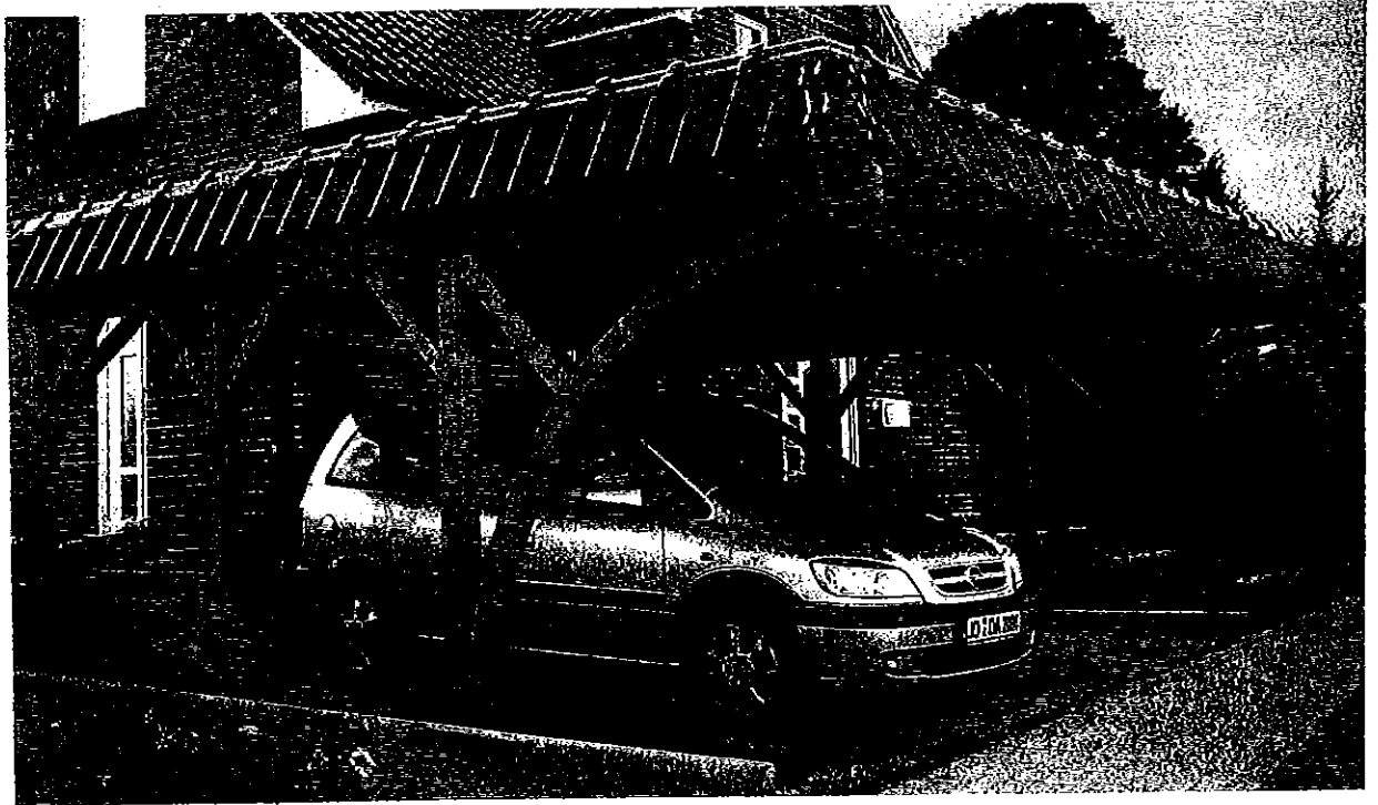
Brelte Einfahrt: Pfostenbogen aus Leimholz. Als bewährt praktische Alternative zum herkömmlichen Pfosten bei engen Einfahrtsöffnungen. Inkl. verstärkter Konstruktion/geänderter Pfostenabstände. Lieferbar für Standard-Durchfahrtshöhe von 210 cm. Rechenbeispiel s. Tabelle
