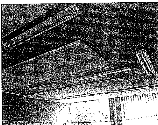
Klassenräume mit neuwertigen Deckenanbauleuchten und Spiegelraster
