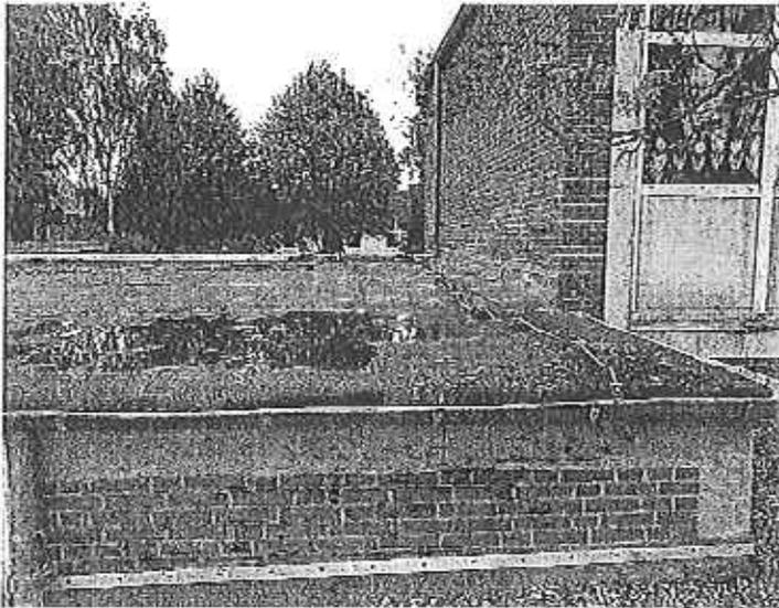
Teilweise ist ein anderer Wandaufbau vorhanden, hier ist die vermutete Konstruktion mit einem 24 cm Gasbeton-Blockstein ausgeführt. Die Konstruktion ist nicht gedämmt.
