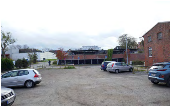
Abb. 48: Temporäres Parken und bestehendes Parkdeck am Stadtgraben
