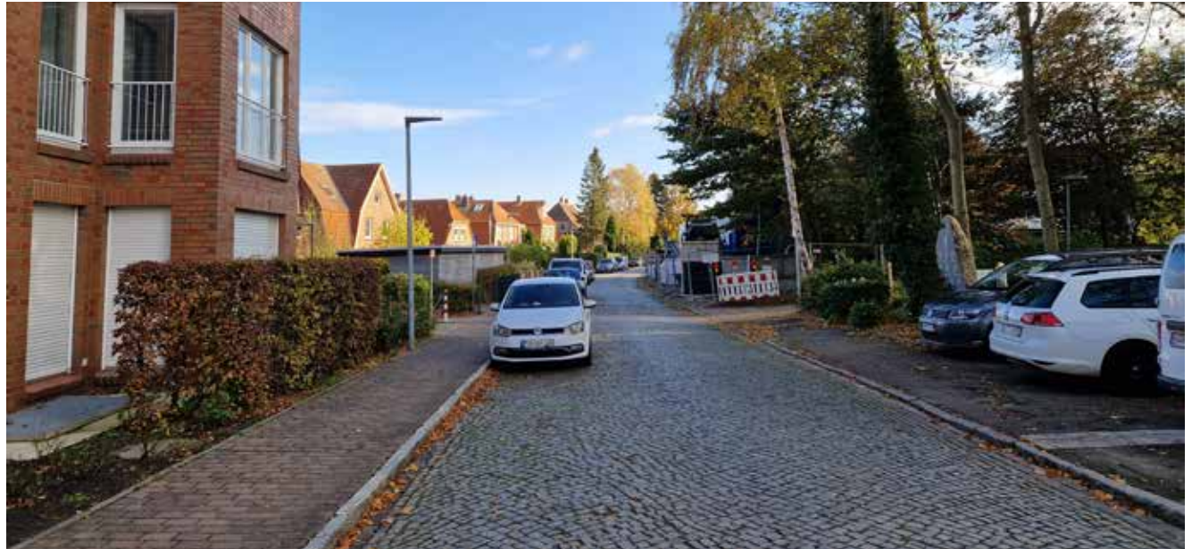
Kleinsteinpflaster in der Friedrich-Ebert-Straße
