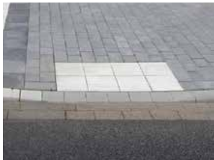
Richtungsfeld mit abgesenkter Bordkante
