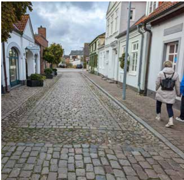
Mix im Bodenbelag - Großsteinpflaster, Lesestein- und, Betonsteinpflaster
