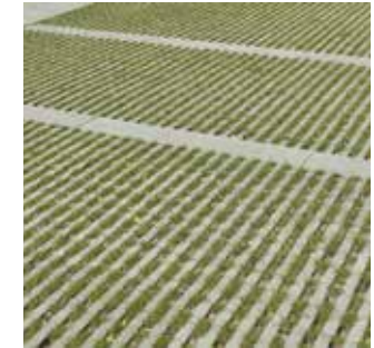
Rasenliner. Begrüntes und sickerfähiges Pflaster (grau) aus gefüggedichtem Beton mit linearen Rasenfugen.
