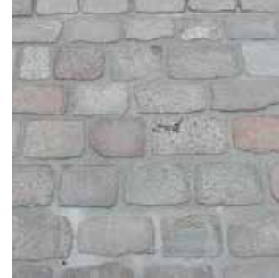
Granitgroßsteinpflaster rotbunt geschnitten. Unregelmäßiger Reihenverband, in ungebundener Bauweise.
