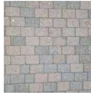
Betonsteinpflaster rotbunt. 1/3 Reihenverband.
