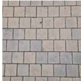
Betonsteinpflaster sandfarben. 1/3 Reihenverband.
