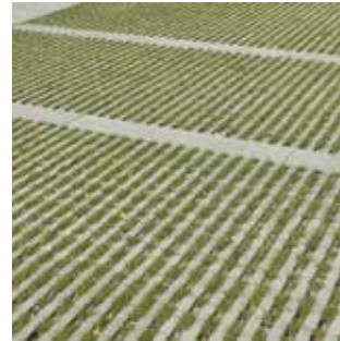
Rasenliner. Begrüntes und sickerfähiges Pflaster (grau) aus gefüggedichtem Beton mit linearen Rasenfugen.
