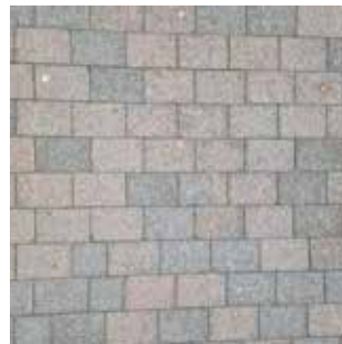
Betonsteinpflaster rotbunt. 1/3 Reihenverband.
