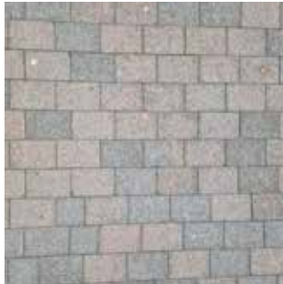
Betonsteinpflaster rotbunt. 1/3 Reihenverband.
