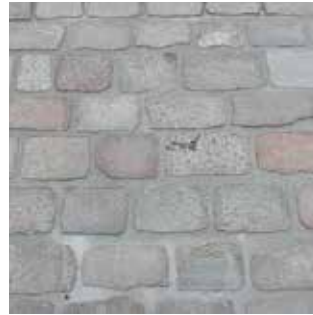
Granitgroßsteinpflaster rotbunt geschnitten. Unregelmäßiger Reihenverband, in gebundener und ungebundener Bauweise.
