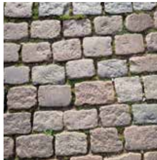
Granitgroßsteinpflaster rotbunt. Unregelmäßiger Reihenverband.
