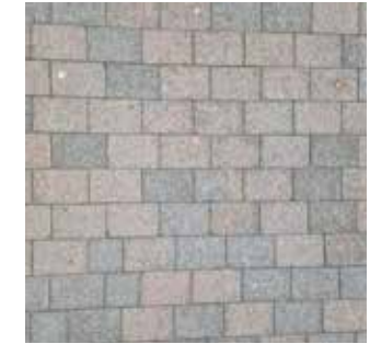
Betonsteinpflaster rotbunt. 1/3 Reihenverband.
